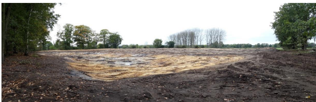
Figuur 15 - Infiltratiepoel Herentals net na uitvoering werkzaamheden (september 2022)
