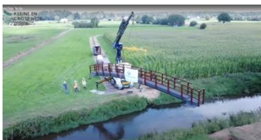
Plaatsing wandelbrug over de Aa
