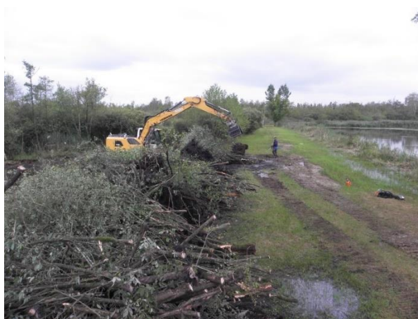
Figuur 54 - Uitvoering werkzaamheden (2022)
