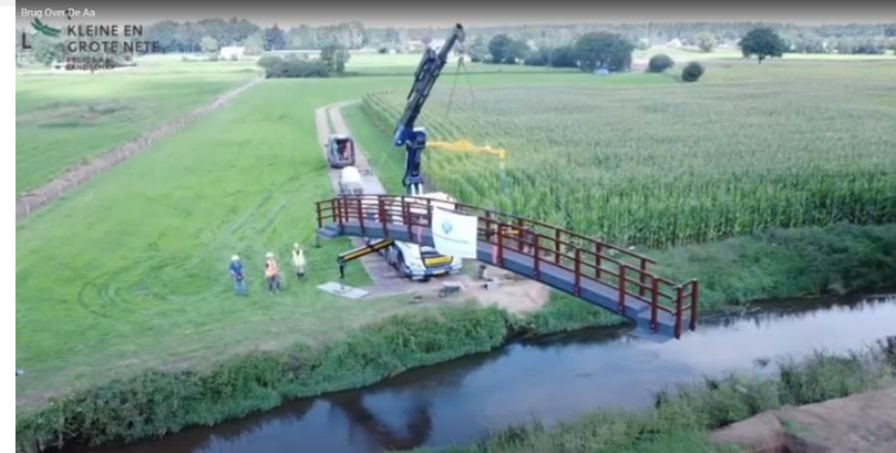
Plaatsing wandelbrug over de Aa
