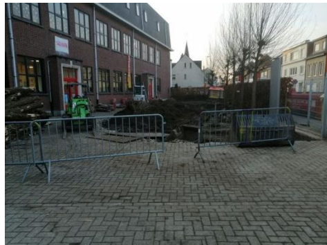
Rondom 2 scholen in Nijlen – wegnemen klinkerverhardingen
