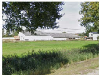
De Vlaamse Landmaatschappij en provincie Antwerpen willen deze oude hoevegebouwen afbreken en alle verhardingen opbreken. www.vlaanderen.be
