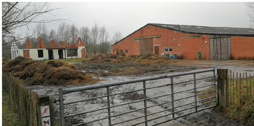
Boerderij De Stolp was in 2019 al grotendeels gestript toen de werken werden stilgelegd. Nu moet alle bebouwing verdwijnen en wordt het gebied teruggegeven aan de natuur. FOTO HANS OTTEN
